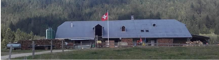
Ci-contre : la première ferme Suisse
