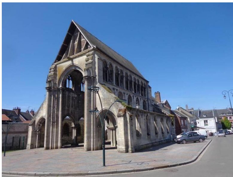
Pointage de Doullens de 12h53 à 13h10. L'église Saint-Pierre en ruine
