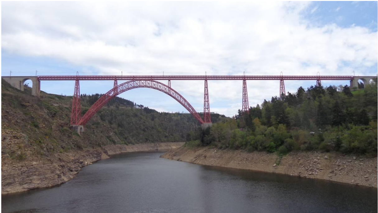
Ci-dessus : Gustave EIFFEL construisit ce viaduc ferroviaire afin d'enjamber les gorges de la Truyère
